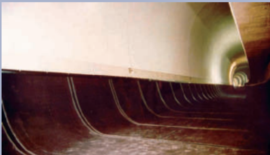
Рис. 6: Виброизоляционные маты USM® в тоннеле до балластирования.
