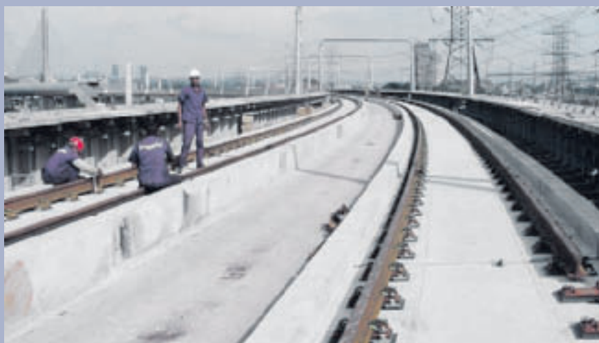
Рис. 8: Виброизоляционные маты USM®, уложенные под бетон на ж/д эстакаде.
