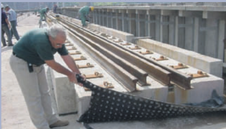
Рис. 11: Оголенная «облегченная» система масса-пружина с виброизоляционными матами USM®.
