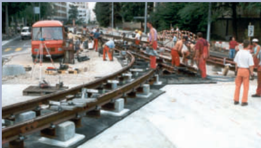
Рис. 12: «Облегченная» система масса-пружина с виброизоляционными матами USM® для дорог.
