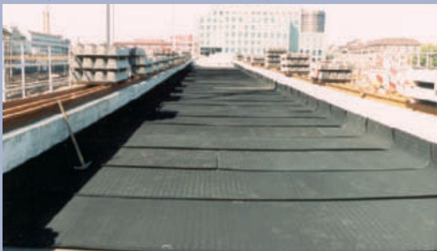
Рис. 7: Виброизоляционные маты USM® на бетонном мосту до балластирования.
